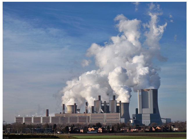
그림 6. 니더아우셈 발전소 전경. 사진: Stodtmeister CC BY 3.0
