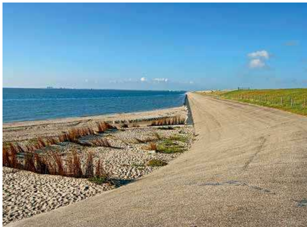
그림 24. 아스팔트 제방 전방 바다 쪽에 사구 띠를 조성하여 장기적으로 염생 습지를 얻는 새로운 방법이 고안되었다. © J. Fröhlich.
