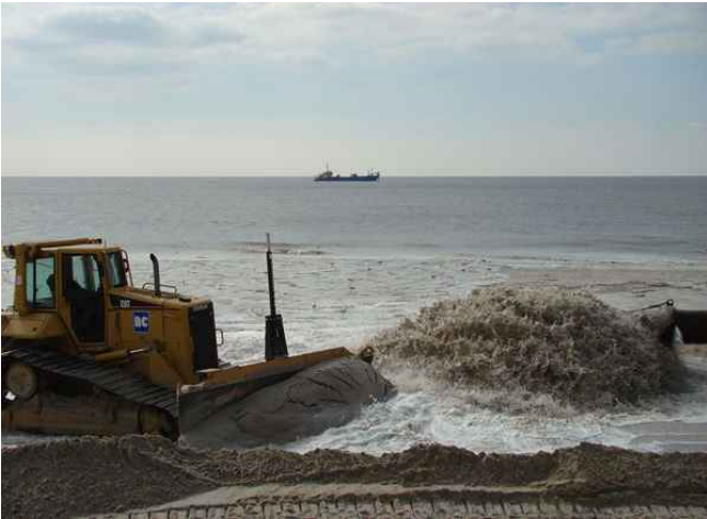
그림 7. 주입한 모래를 포크레인으로 분산. 뒤쪽 수평선에 포크레인 선박. © Hajotthu. CC BY-SA 3.0
