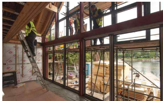
그림 17. 건물의 무게중심을 깊게 잡는 것이 관건. 상부는 부유할 수 있는 가벼운 소재. 하부는 부유하는 상층의 무게를 받칠 수 있도록 무거운 철근콘크리트 소재로 구축. 사진: Baca Architects, London.
