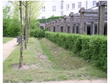
카포트, 주차공간을 트렐리스 로 녹화하고 앞쪽에 우수 침투 로 설치
